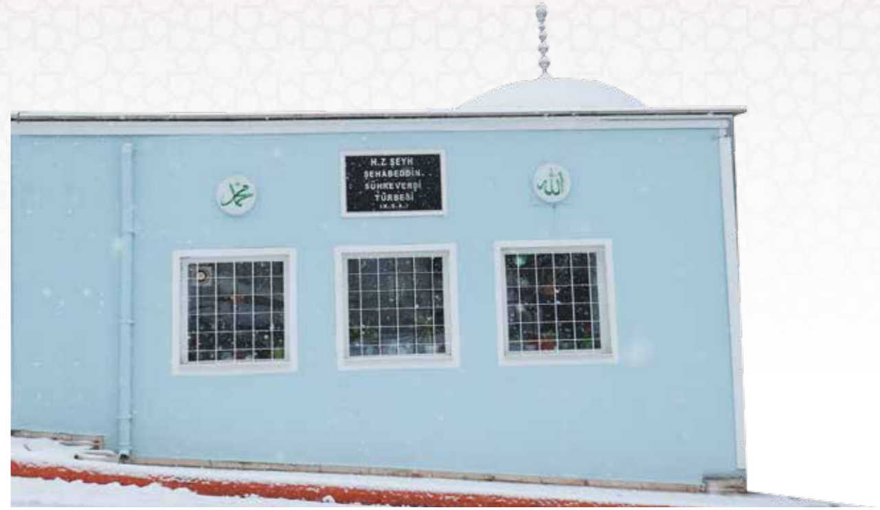
Hz. Şeyh Şehâbeddin Sühreverdî Türbesi, Odunpazarı-Eskişehir
